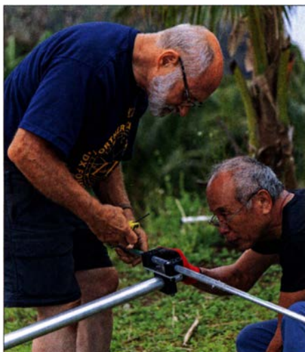
Glenn, W0GJ (l.), und Harumi, JR4OZR, installieren eine 3-Element-Yagi-Antenne.
